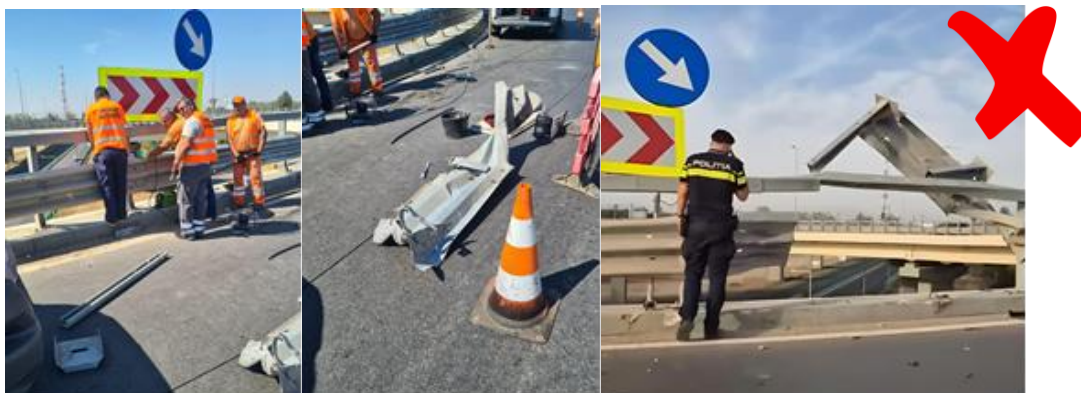
Figura 1,2,3: Detalii coliziune parapete (Pasaj Berceni, București). Calitatea materialelor si a instalării sunt investigate. Accident soldat cu decesul conducătorului auto si cedarea parapetului de siguranța.
