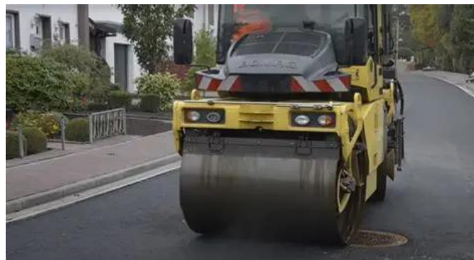
Figura 2: Compactarea capacului împreună cu stratul asfaltic
